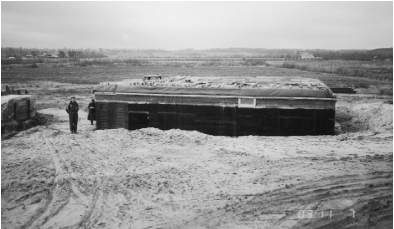
Neubau des Wohnhauses Ksenofontow Stand November 2003, diesen Winter wird die Familie bereits ein Zimmer bewohnen, das Dach wird allerdings noch provisorisch sein.
